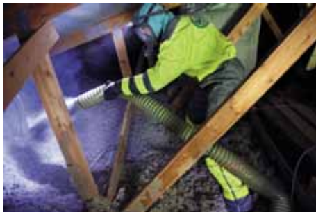
Kuva 42. Yläpohjan lisälämmöneristystä puhallusvillalla (kuva Termex-Eriste Oy).
